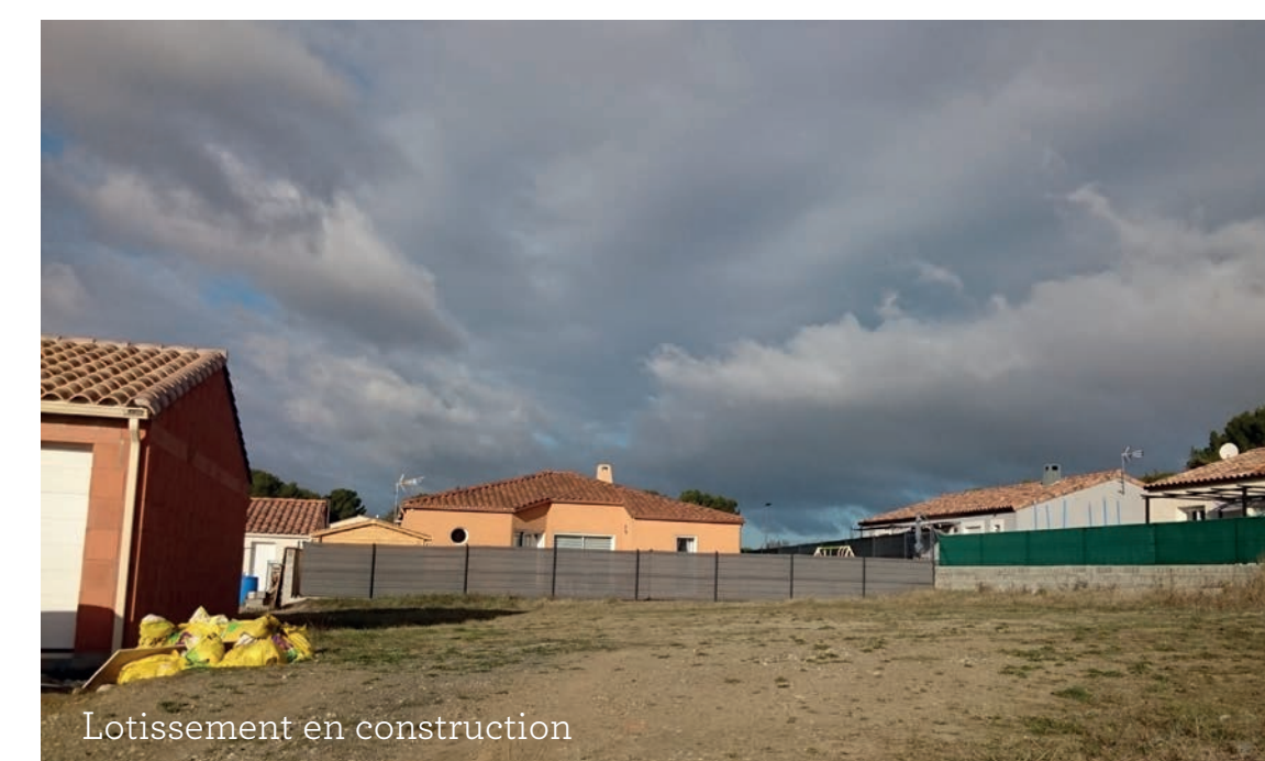
Lotissement en construction
