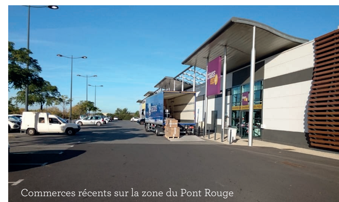
Commerces récents sur la zone du Pont Rouge
